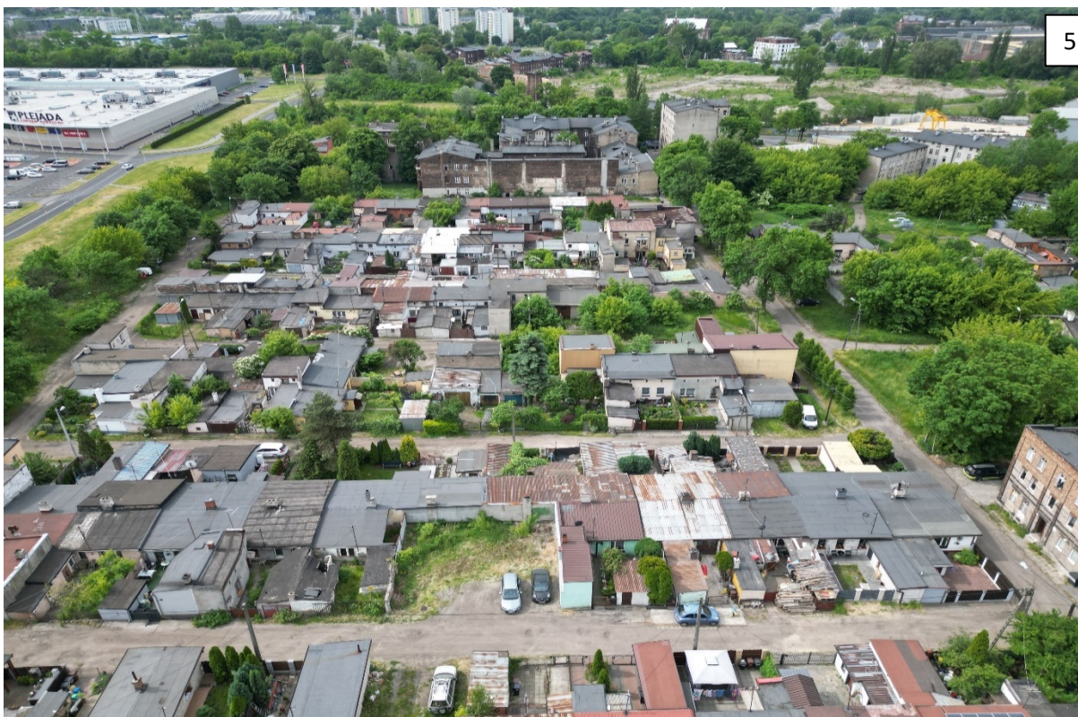
1-2. Zdekapitalizowana tkanka mieszkaniowa na ulicy Robotniczej. 3. Zły stan dróg i chodników. 4. Brak kanalizacji. 5. Widok na zdekapitalizowaną tkankę mieszkaniową dzielnicy.
